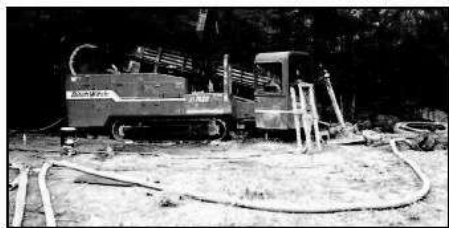
Рисунок 6.17 Прокладка трубопровода методом горизонтально направленного бурения.
