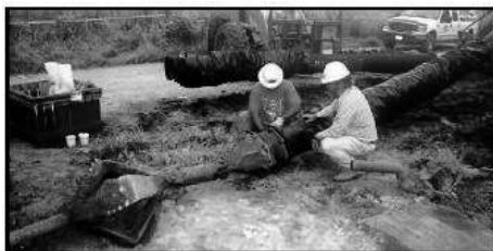
Рисунок 6.17 Прокладка трубопровода методом горизонтально направленного бурения.
